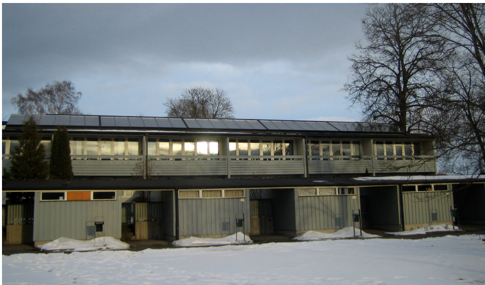
Figur 1: Solvärmeanläggning på Apelvägen 49, Örebro.
